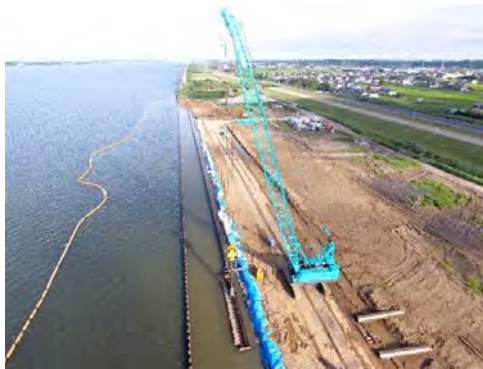
【川の中へ鋼矢板を打設中！】 撮影者会社名・撮影者：岡田土建(株) 石毛龍介
