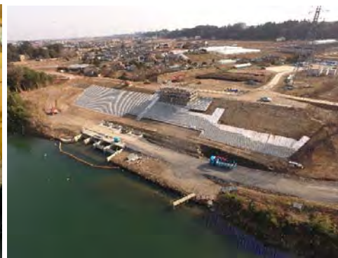
【護岸ブロックでテトリス】 撮影者会社名・撮影者：金成重機建設(株) 佐藤和摩
