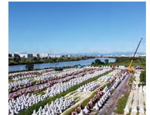
【根固めブロック製作中】 撮影者会社名・撮影者：多田建設(株) 天戸雄介
